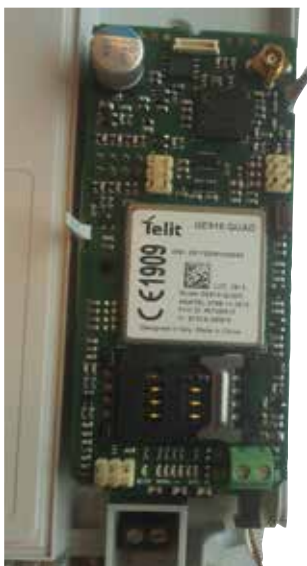
Bilde 19. Montering av jordfeilmodul med OMNICON 2G MODEM.
