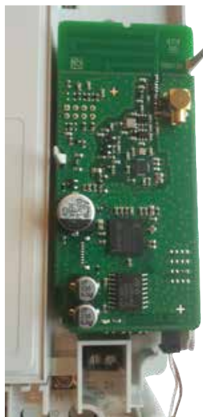
Bilde 21. Montering av jordfeilmodul og OMNICON MUC-modul.
