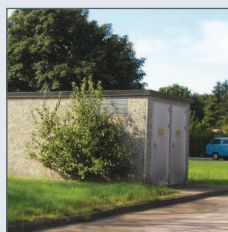
Fuktighet Temperatur Jordingsfeil Kortslutning
